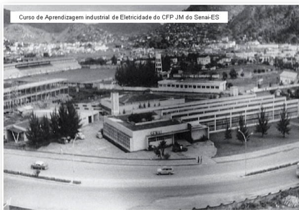
Figure 3. Vista externa da Escola de Aprendizagem Jerônimo Monteiro e do Centro de Treinamento em 1964.
